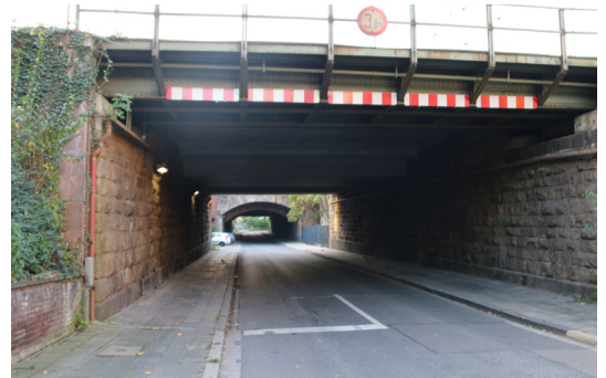
ABB 034 Unterführung Salzstraße Quelle: SSR
