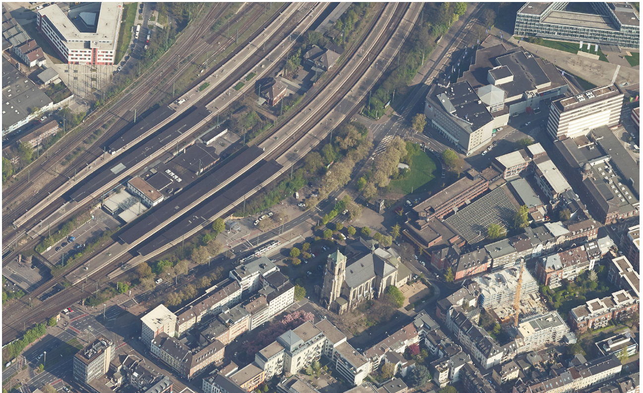
ABB 054 Schrägluftbild des Theodor-Heuss-Platzes Quelle: Stadt Neuss, Aerowest 2017
