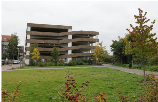
ABB 031 Rückseite Parkhaus Further Straße Quelle: SSR
