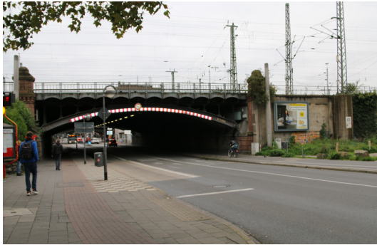
ABB 023 Unterführung Further Straße Quelle: SSR
