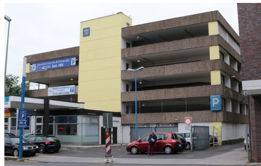
ABB 030 Parkhaus Further Straße Quelle: SSR
