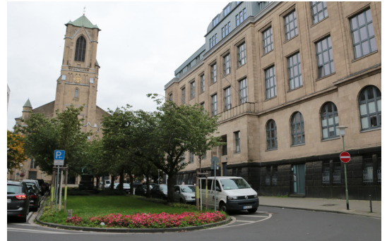
ABB 032 Situation am Marienkirchplatz Quelle: SSR
